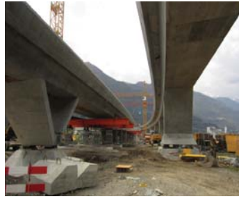
Viadukt Bellinzona-Lugano (links) und Lugano-Bellinzona (rechts)
