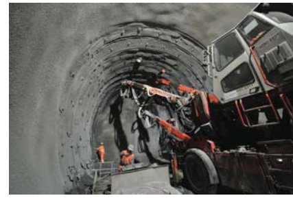
Baustelle Sigirino Photos Alp Transit San Gottardo SA
